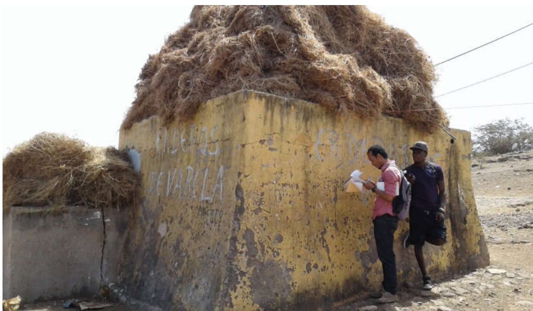
Figura 12 – Reservatório de água
